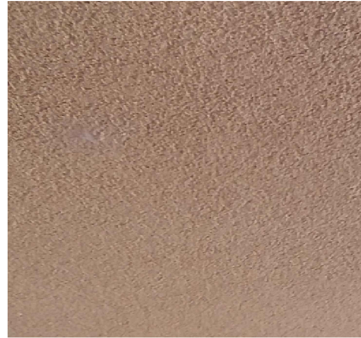
6 EXISTING STUCCO PICTURE SCALE:
