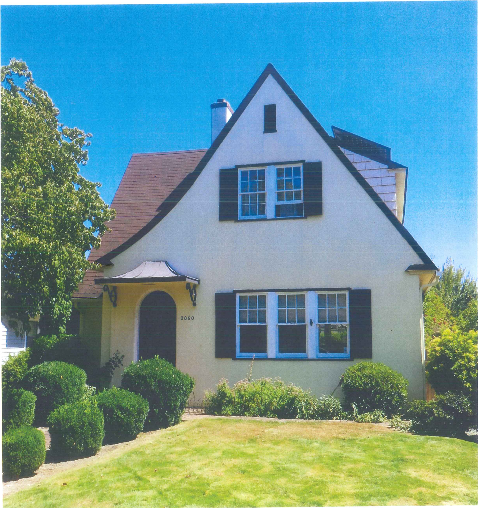
2060 High St SE - Exterior
