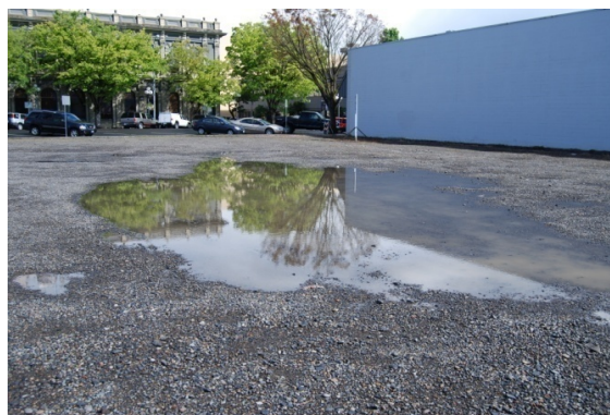
Figura 4. Las superficies de grava que han sido sujetas al tráfico de vehículos se comportan más como superficies pavimentadas y se consideran impermeables.
